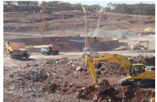
◆ Идет строительство нефтеплощадки в Козьмино, 2009
